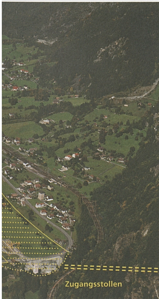
Luftaufnahme von Silenen, Sommer 1999; der Blick geht Richtung Norden. Die Ebene zwischen den beiden Wohnquartieren Grund und Dörfli in Silenen wird zur Grossbaustelle.
