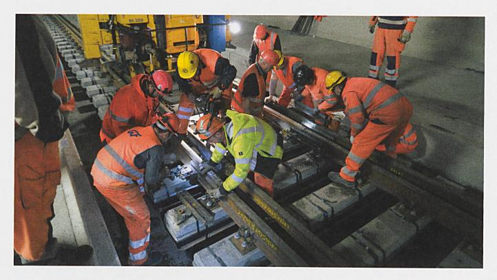
Un elemento di fondamentale importanza per l'esercizio ferroviario all'interno della Galleria di base del Ceneri è lo scambio nr. 74 presente in sotterraneo nella canna ovest a circa 480 metri dall'imbocco della galleria al portale nord e si sviluppa per ca.140 metri sul tracciato.
