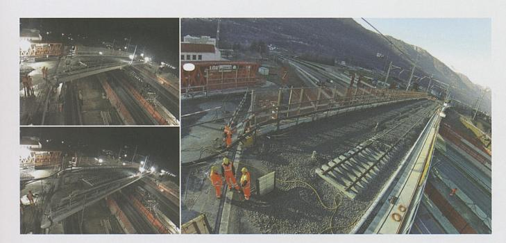
Nella notte tra sabato 9 e domenica 10 marzo 2013 il cantiere AlpTransit del Nodo di Camorino è stato teatro della traslazione di 14.56 metri del ponte ferroviario sopra l'autostrada A2. Una spettacolare operazione che ha visto impiegati più di 100 tecnici.
