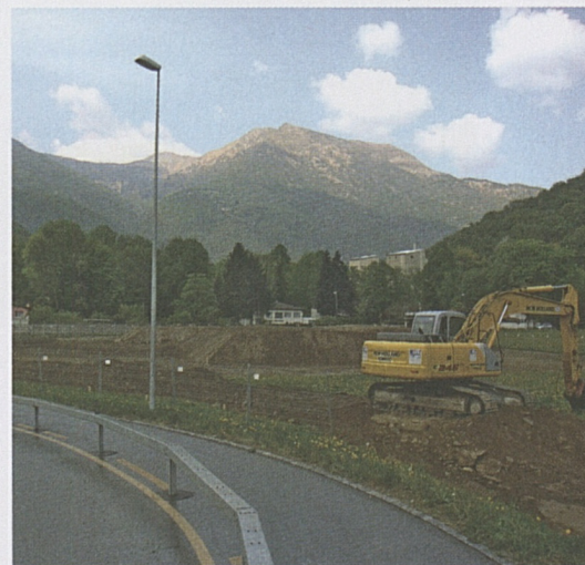
Inizio dei lavori al Dosso di Taverne.
