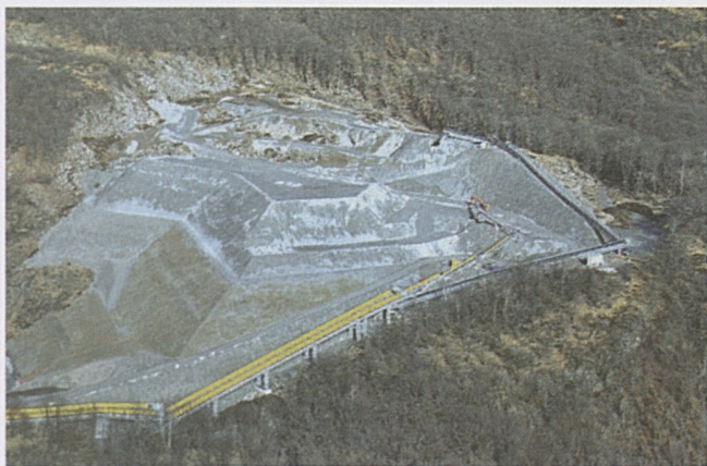
Sigirino: deposito definitivo del materiale.
