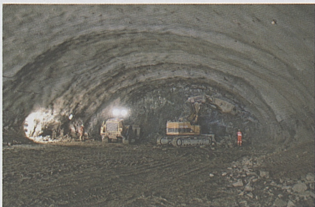
Vigana: avanzamento in calotta.
