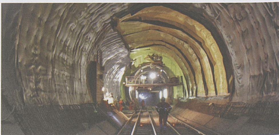
Applicazione isolamento.
