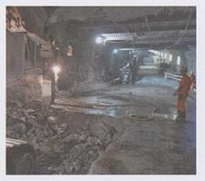
per permettere l'avanzamento dei lavori di sistemazione interna. Inoltre per permettere di eseguire i lavori per le banchine tra il portale e la stazione multifunzionale sono stati effettuati dei controlli con una telecamera mobile e i lavori di pulizia del sistema dei tubi di drenaggio dell'acqua della galleria.
