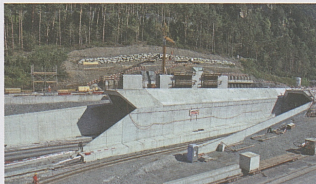
Erstfeld: galleria a cielo aperto.
