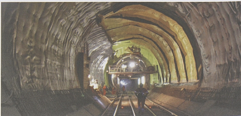
Applicazione isolamento.
