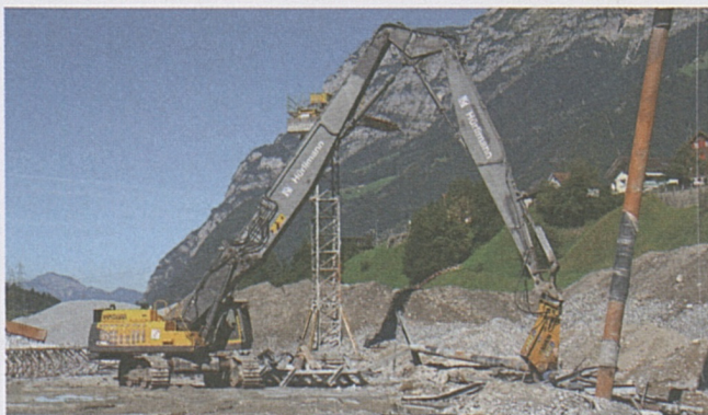
Amsteg: lavori di smontaggio.
