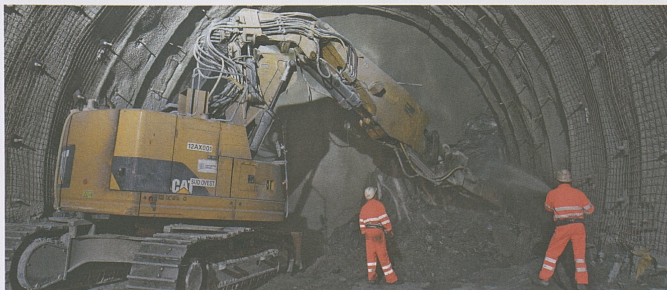
Sopra: deposito definitivo del materiale. Sotto: avanzamento con martellone nella zona geologicamente disturbata della linea della Valcolla
