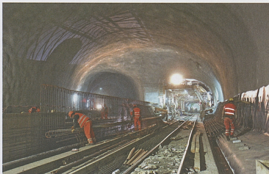
Lavori di sistemazione interna ad Amsteg.
