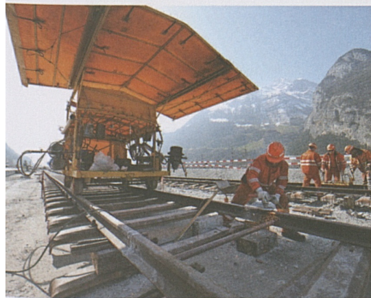
Lavori per il piazzale d'installazione tecnica ferroviaria ad Altdorf-Rynächt.
