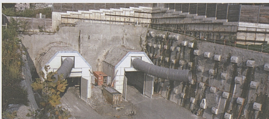
Il portale di Vezia con le installazioni di ventilazione e protezione fonica.
