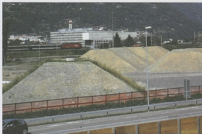
Camorino: rilevati di precarico dei futuri viadotti a nord della strada cantonale.
