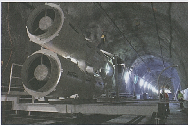
Sigirino: installazione dei tubi della ventilazione.
