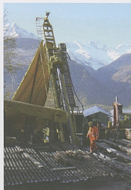
Ad Anzonico, preparativi per una trivellazione verticale di circa 920 metri.
