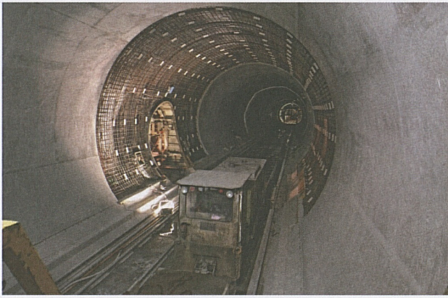
Sedrun: armatura della canna ovest.
