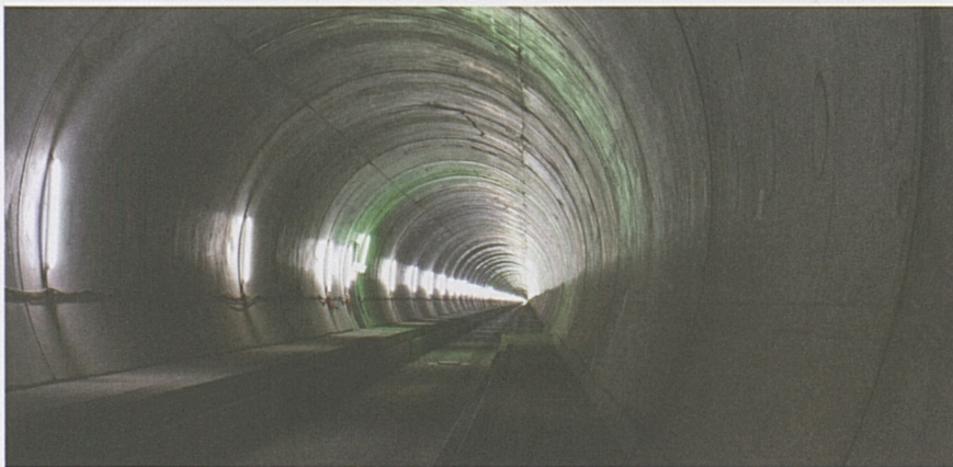
Anche il comparto Amsteg attende ormai l'inizio dei lavori di tecnica ferroviaria.
