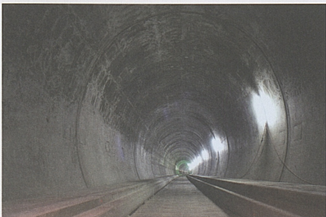
Un tratto della canna ovest, pronta per l'inizio dei lavori di tecnica ferroviaria.
