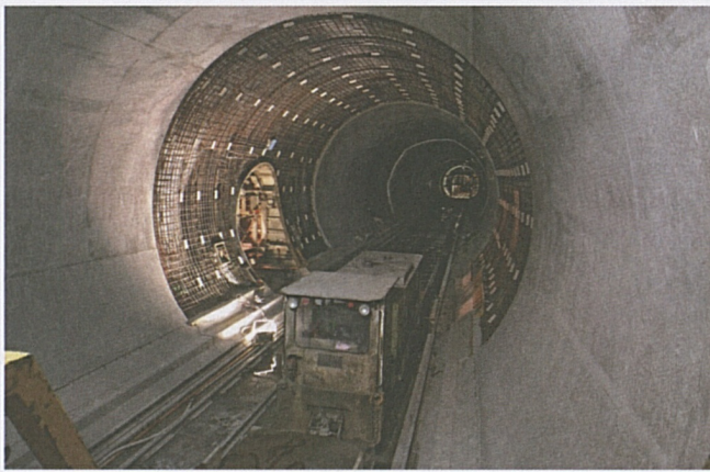
Sedrun: armatura della canna ovest.
