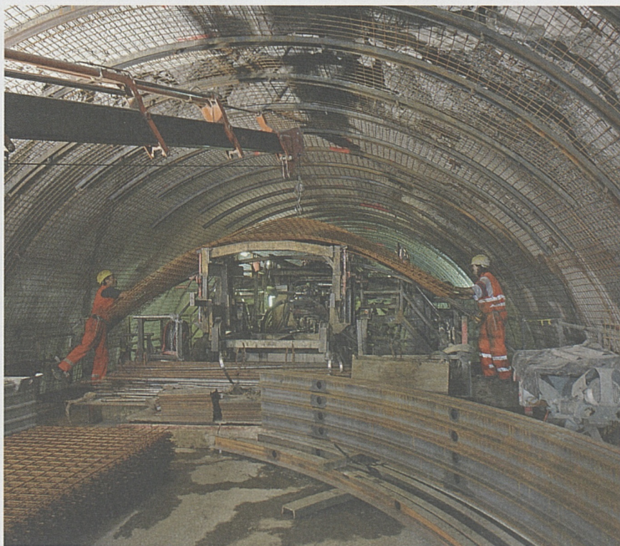
Tubo est: minatori stanno montando centine reticolari.
