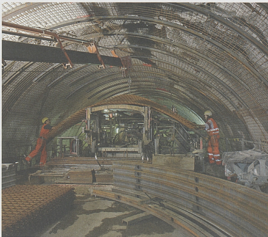
Tubo est: minatori stanno montando centine reticolari.
