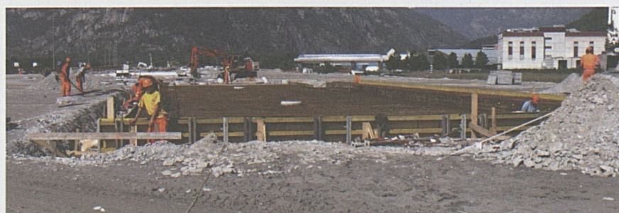
Lavori sull'area d'installazione della tecnica ferroviaria.
