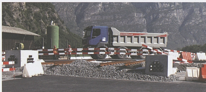
Posa del binario di cantiere.
