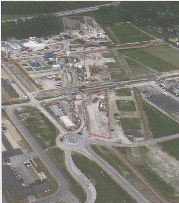
L'ampia area di cantiere antistante i due portali di Vigana.
