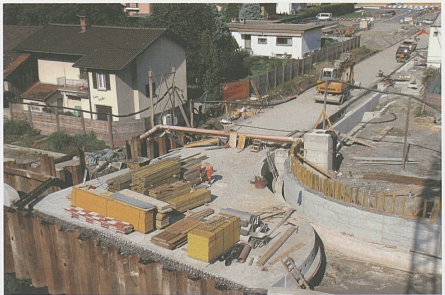
Realizzazione della zona di innesto-imbocco del canale fugatore.
