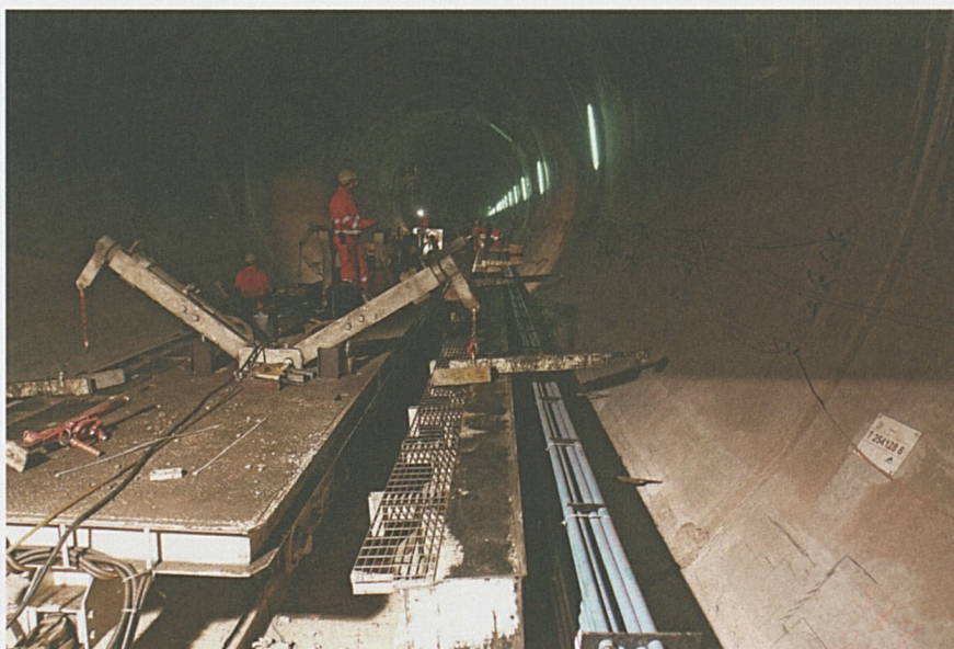
Preparazione dei cassoni per il betonaggio delle banchine laterali.
