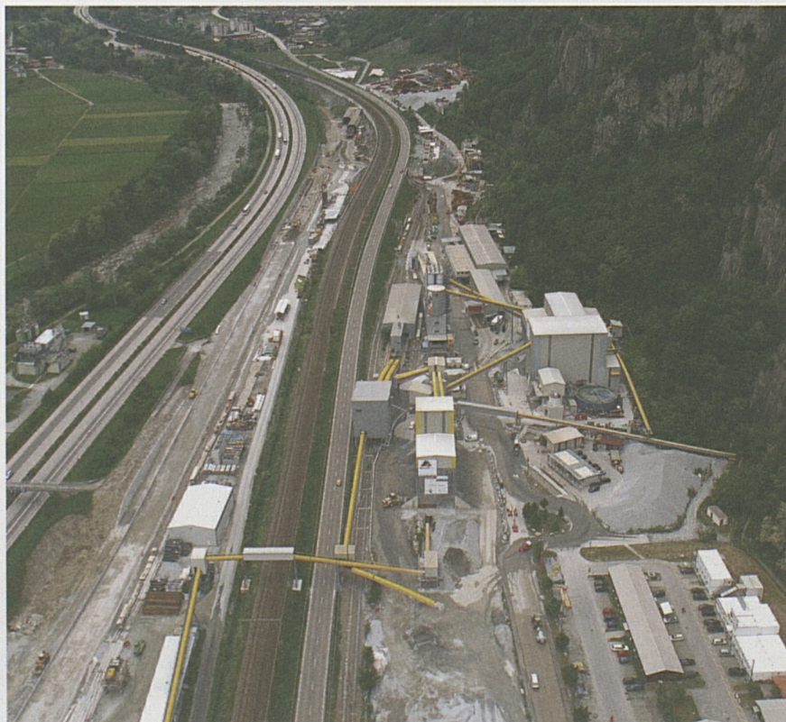
Panoramica aerea del nucleo del cantiere esterno di Bodio.
