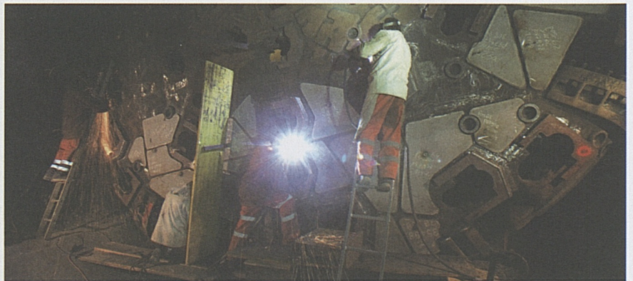
Lavori di revisione alla testa della fresa.
