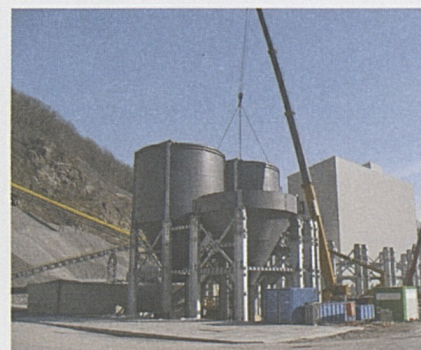
Sili per la raccolta del materiale di scavo.
