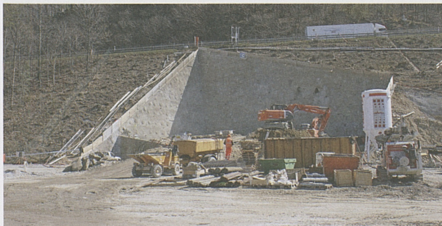
Installazione di cantiere davanti ad uno dei due portali.
