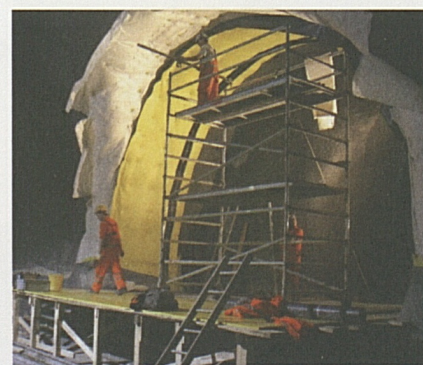
Lavori d'impermeabilizzazione.
