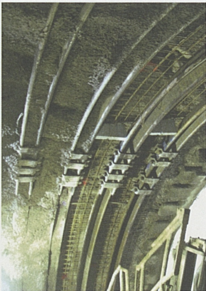
Messa in sicurezza: centine metalliche e calcestruzzo spruzzato.
