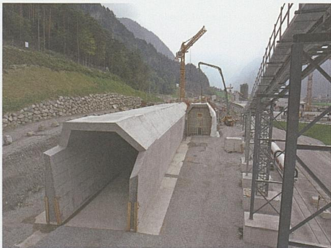
Nel tubo est a fine febbraio 2008 sono stati realizzati i primi metri della platea in calcestruzzo.
