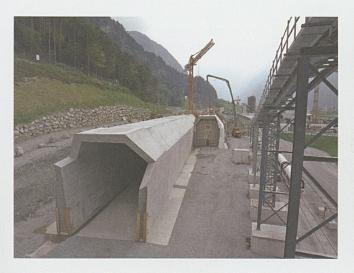
Nel tubo est a fine febbraio 2008 sono stati realizzati i primi metri della platea in calcestruzzo.
