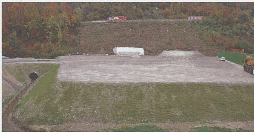
Zona portale nord della Galleria di base del Ceneri.
