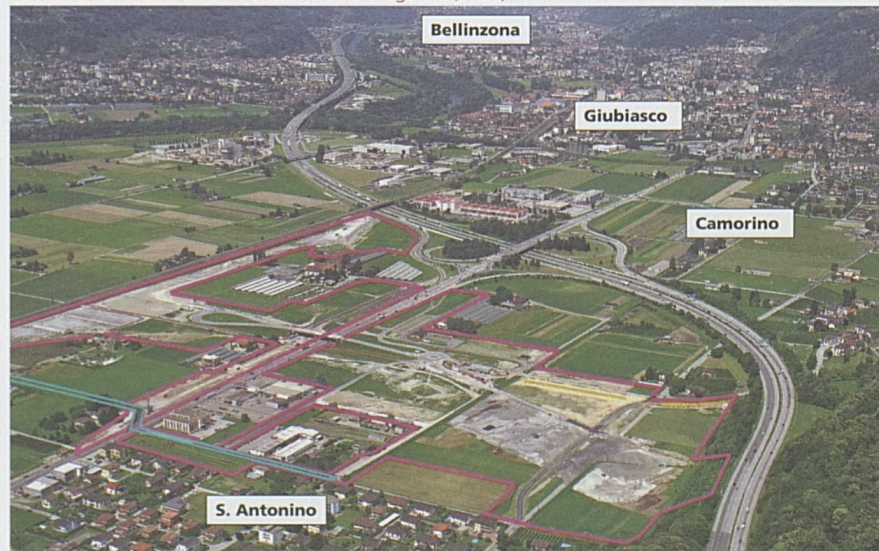
Perimetro dell'area di cantiere attuale e canale fugatore (in blu)
