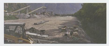
Sono iniziati i lavori per la realizzazione del tracciato tra la via Mondai e il portale della galleria di base. Entro l'autunno del 2009 sarà approntato il rilevato ferroviario che permetterà la posa del binario di montaggio della tecnica ferroviaria e l'inizio della posa delle infrastrutture elettromeccaniche nel tubo ovest da parte del consorzio Transtec Gotthard.
