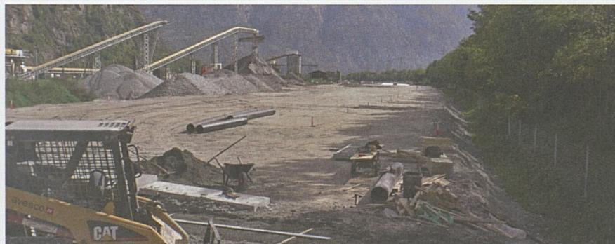
Sono iniziati i lavori per la realizzazione del tracciato tra la via Mondai e il portale della galleria di base. Entro l'autunno del 2009 sarà approntato il rilevato ferroviario che permetterà la posa del binario di montaggio della tecnica ferroviaria e l'inizio della posa delle infrastrutture elettromeccaniche nel tubo ovest da parte del consorzio Transtec Gotthard.
