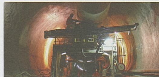
Tubo est: lavori di rivestimento.
