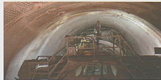
Tubo est: lavori di rivestimento.
