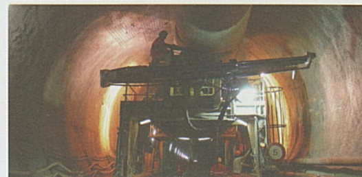
Tubo est: lavori di rivestimento.
