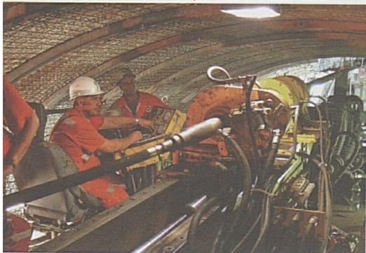
Operai al lavoro nella perforazione della Piora.
