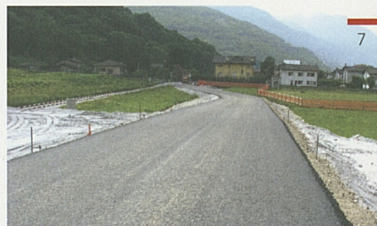
Lavori per lo spostamento della Via Ai Lischee.
