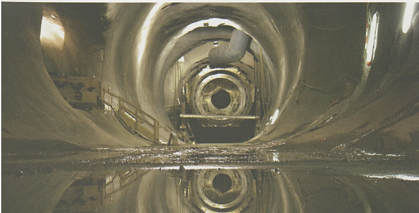
Foto sotto: fresa nel tubo ovest durante lo smontaggio.
