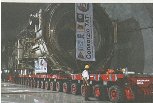
Foto sopra: spostamento della fresa nel tubo ovest.
