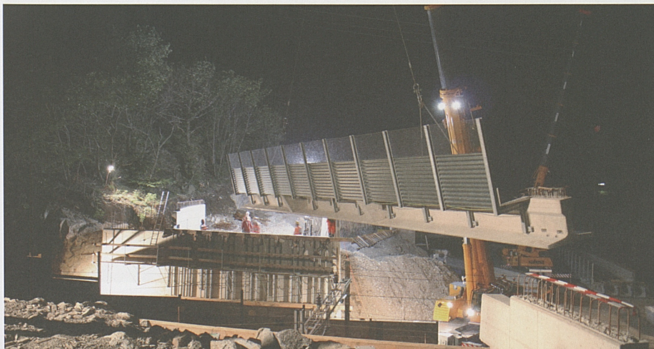
Foto sotto: posa notturna del manufatto provvisorio.
