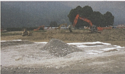
Foto sopra: le prime ruspe iniziano a lavorare (stato: aprile 2006).
