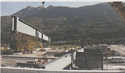
Foto sopra: montaggio del ponte provvisorio.
