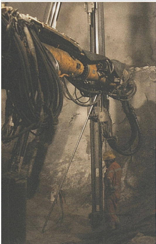
Foto sopra: perforatrice jumbo al lavoro.
