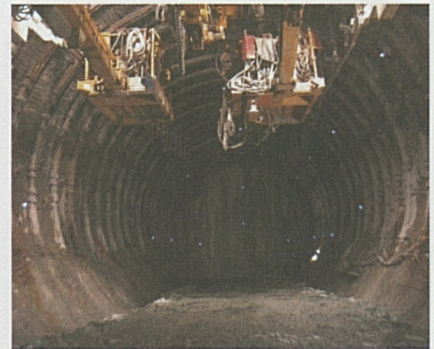
Foto sopra: avanzamento nella roccia spingente.
