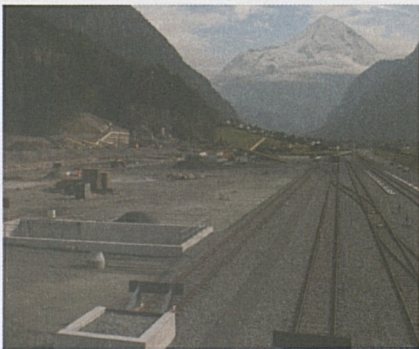
Foto sopra: panoramica del posto d'installazione.
