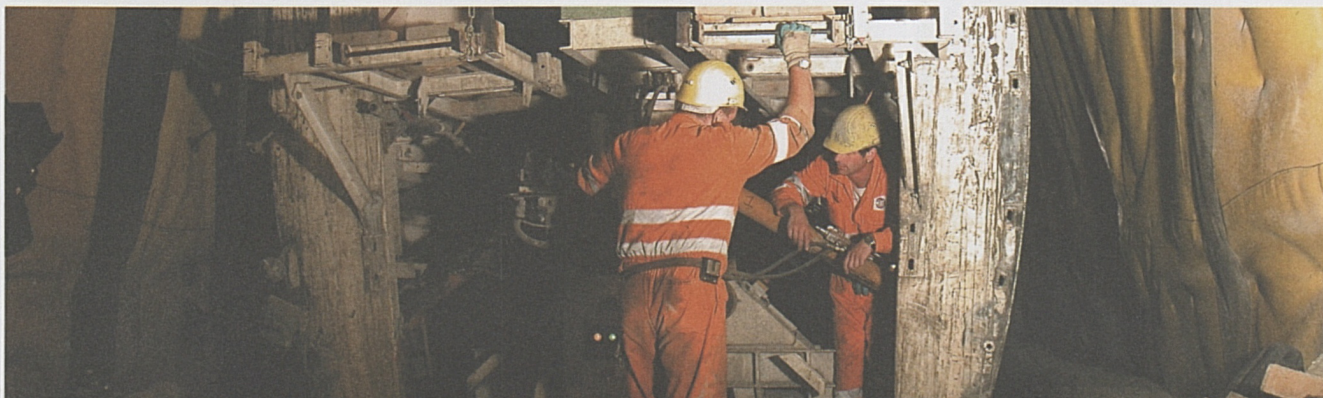
Foto sotto: lavori di betonaggio in un cunicolo laterale.
