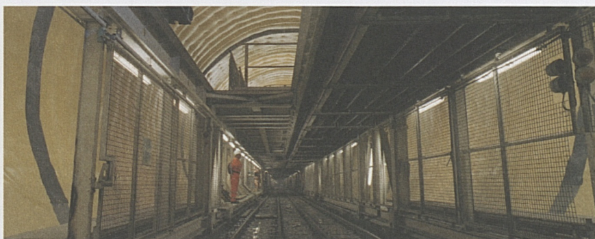
Foto sopra: la struttura del "Wurm" e la volta della galleria impermeabilizzata.
