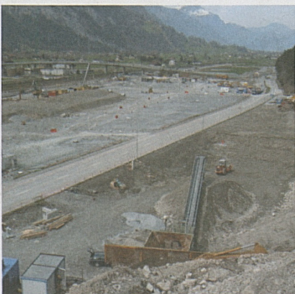
Foto sotto: inizio dei lavori sul cantiere di Erstfeld.
