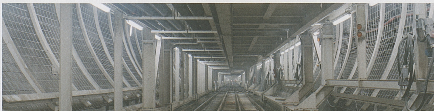
Foto sotto: panoramica di galleria all'interno del "Wurm".
