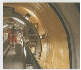
Foto sopra: lavori in galleria a Bodio. Foto sotto: dettaglio dei lavori di impermeabilizzazione.
