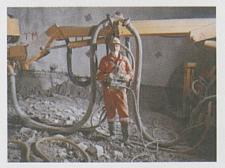
Foto sopra: minatori al lavoro con il perforatore jumbo. Foto in basso: panoramica del cantiere di Faido.
