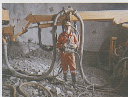
Foto sopra: minatori al lavoro con il perforatore jumbo.
