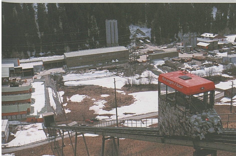
Foto: panoramica del cantiere di Las Rueras a Sedrun.
