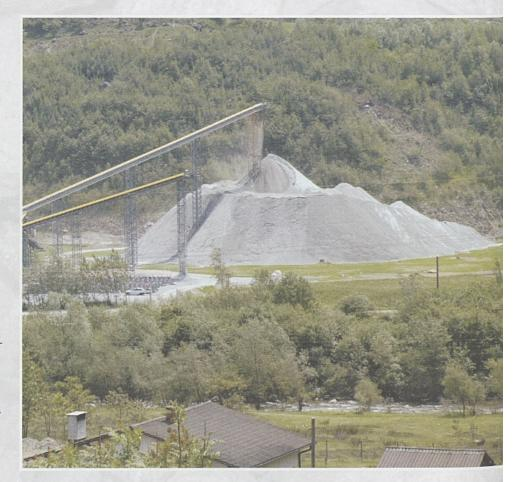
deposito della Cavienca. In totale, dal portale del cunicolo d'accesso di Faido fuoriusciranno 2.5 tonnellate di materiale di scavo. Quella adottata da AlpTransit San Gottardo SA è una soluzione rispettosa dell'ambiente e della popolazione: il trasporto del materiale di scavo avviene su nastri trasportatori, per evitare il transito dei mezzi pesanti sulle strade della Leventina.
