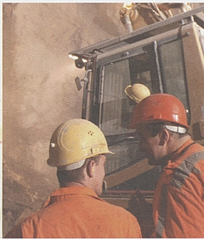
Foto sopra: nonostante la geologia a tratti difficile, nella stazione multifunzionale di Faido i lavori procedono a ritmo intenso.
