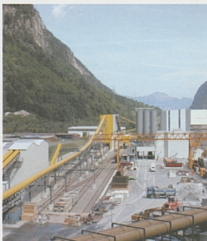
Nella foto sopra: l'area esterna delle installazioni del cantiere di Amsteg.
