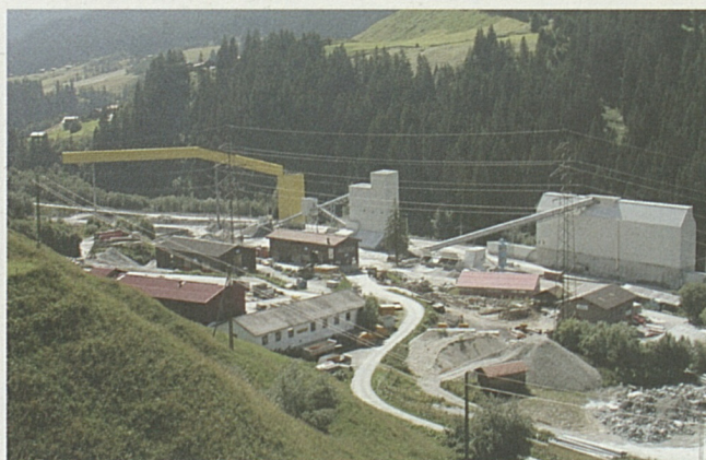
Nella foto sopra: vista panoramica del cantiere di Sedrun.
