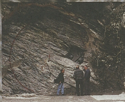
Tre momenti del traforo al portale di Loderio
