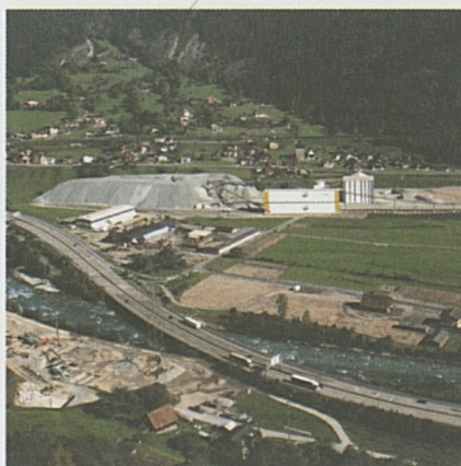
Il cantiere di Amsteg. Visibile il moderno impianto di trattamento del materiale di scavo.
