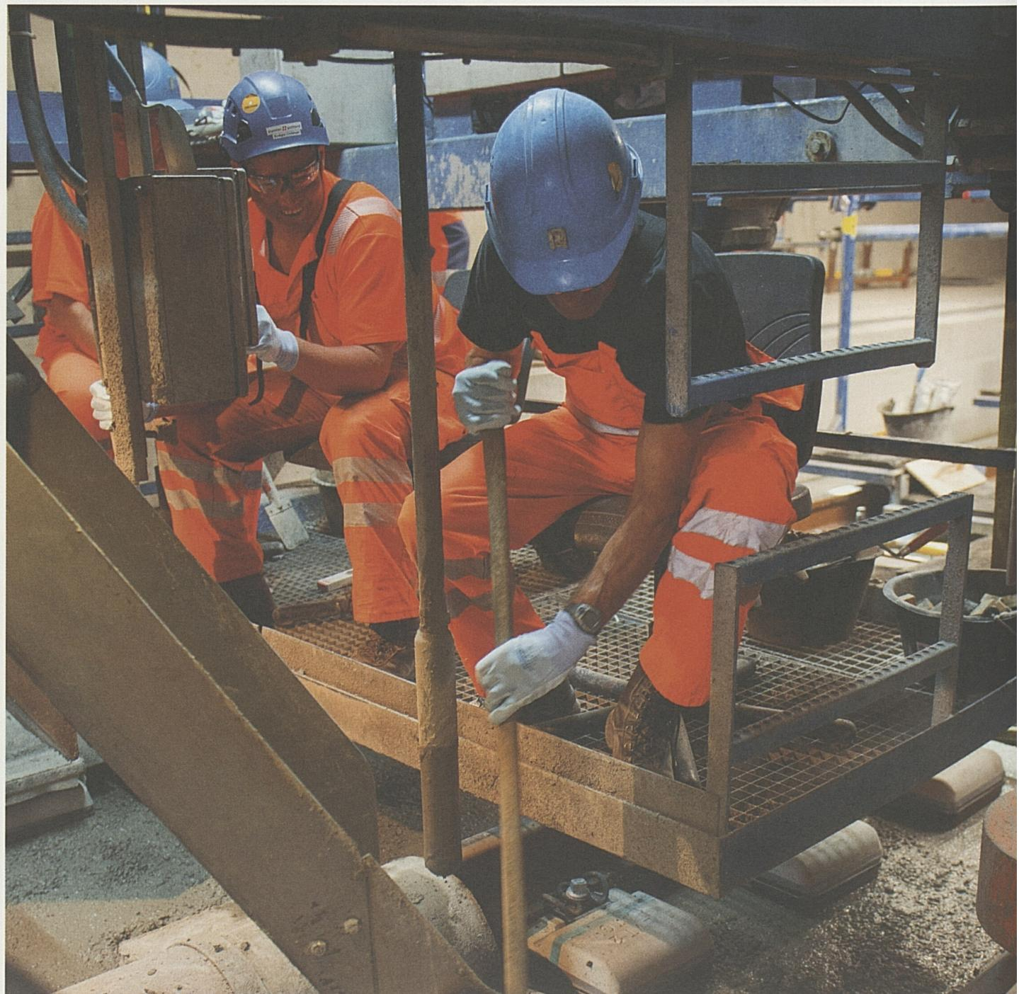
**Am 30. August 2012 hat die Mannschaft des Betonzugs Sedrun erreicht. Damit ist die Feste Fahrbahn in der Oströhre von Erstfeld bis Sedrun eingebaut. Parallel dazu hat der Einbau der Fahrleitung begonnen.**
