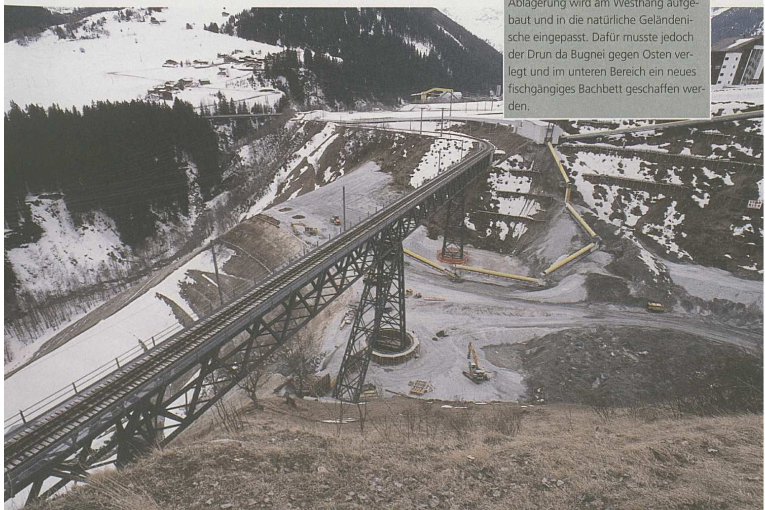
Blick auf die längste, auf Stahl verlegte Zahnradbrücke der Welt.
