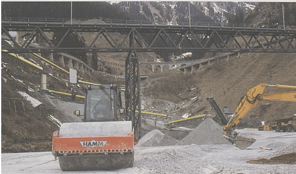
Das Ausbruchmaterial wird in Lagen von 50 cm eingebaut und anschliessend verdichtet.
