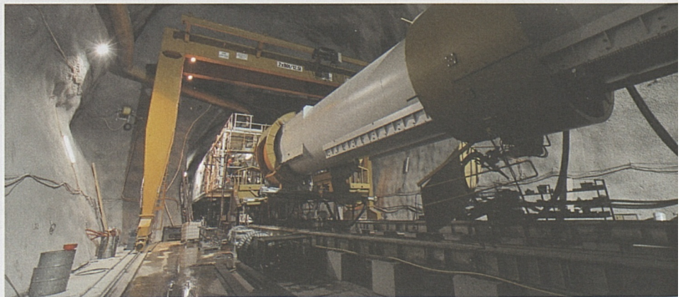
Montage der Tunnelbohrmaschine S-229 in der Oströhre in Amsteg.
