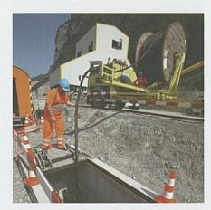
Nordportal Erstfeld: Bereits vor dem Tunnel müssen Kabel für die Bahntechnik eingezogen werden.
