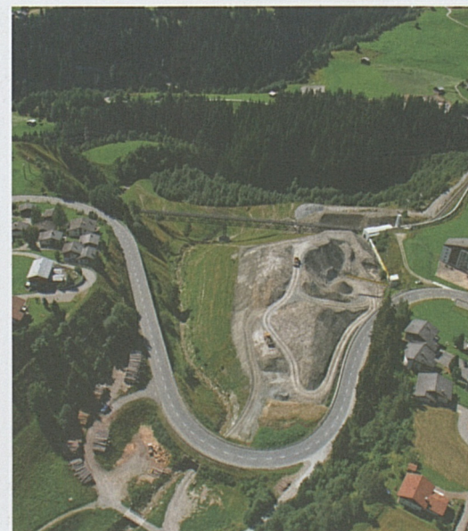
Die Deponie Val da Claus in Sedrun.
