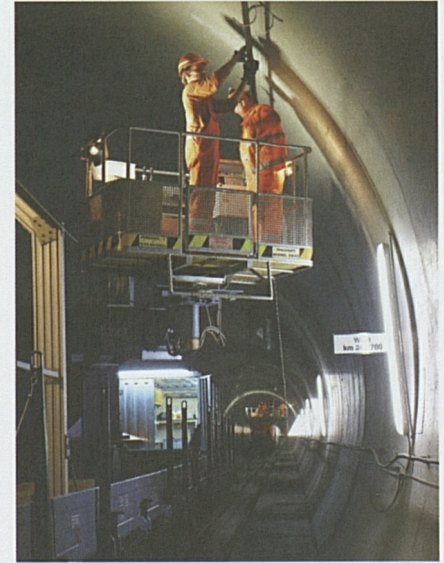
Bodio: Montagearbeiten für die Bahntechnik.
