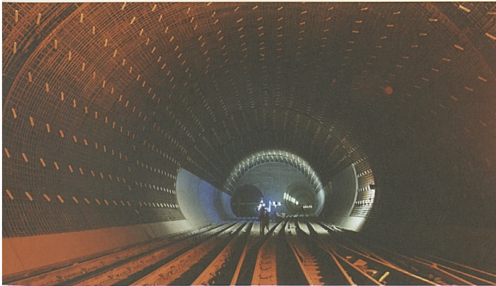
Faido: Armierte Tunnelwechselaufweitung – bereit für die Betonarbeiten.
