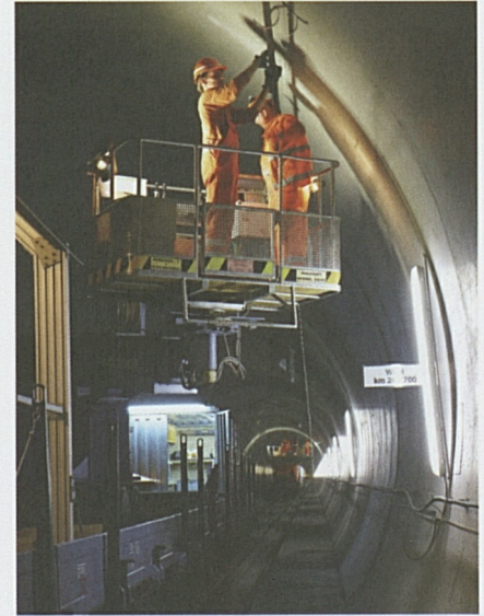
Bodio: Montagearbeiten für die Bahntechnik.
