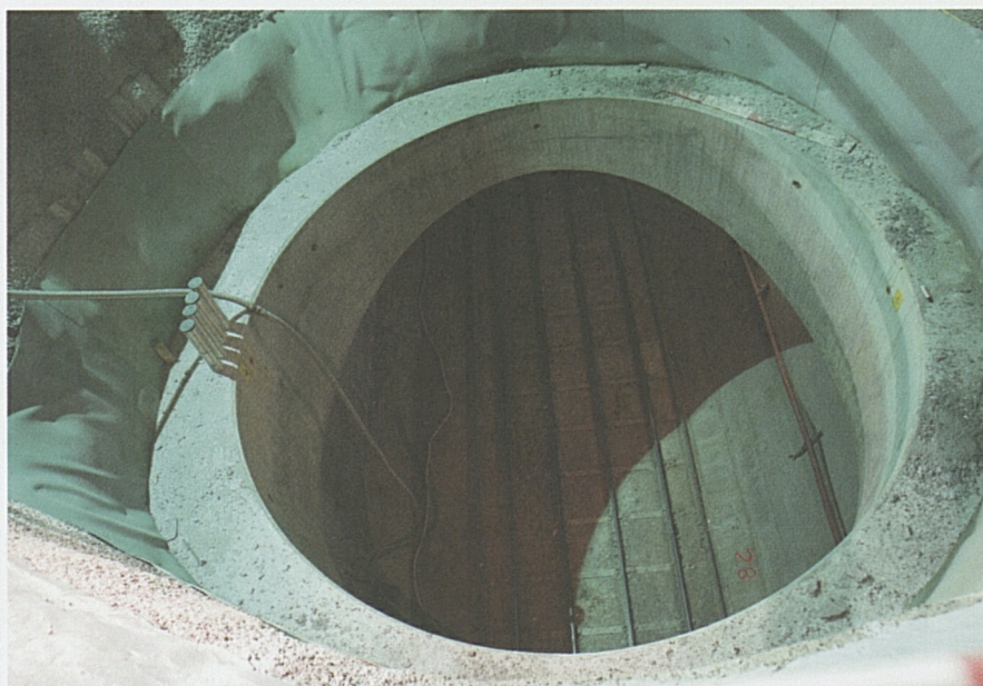
Faido: Abluftschacht mit Blick in die Weströhre.
